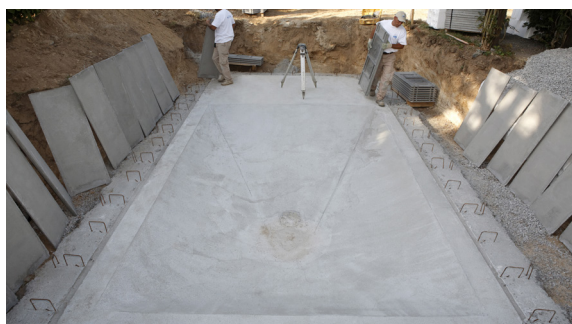
3 - Disposition des panneaux de la structure
