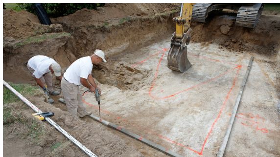
1 - Terrassement et marquage de la future forme de fond
