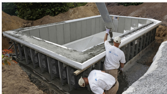
5 - Coulage du béton pour les chaînages haut et bas
