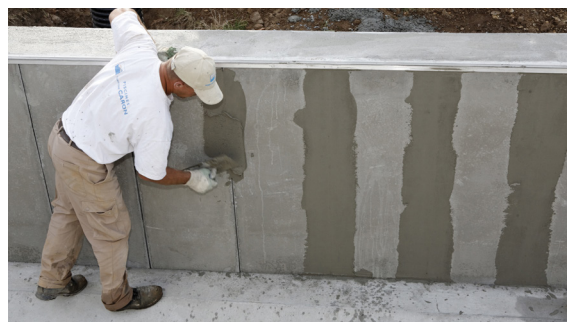
6 - Préparation du bassin avec les finitions
