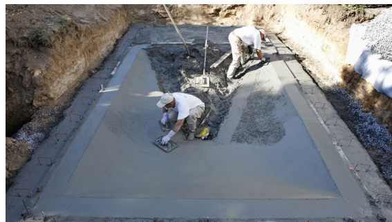
2 - Réalisation de la forme de fond après coulage du radier
